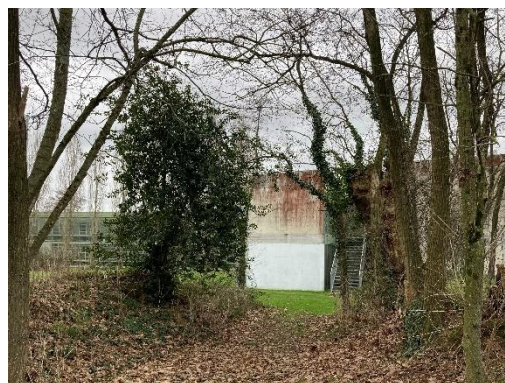
Espace boisé situé à l'extrémité du bâtiment
