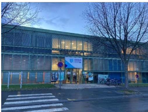
Entrée principale du bâtiment depuis la rue Aristote
