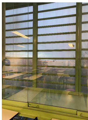
Double peau constituant la façade du bâtiment
